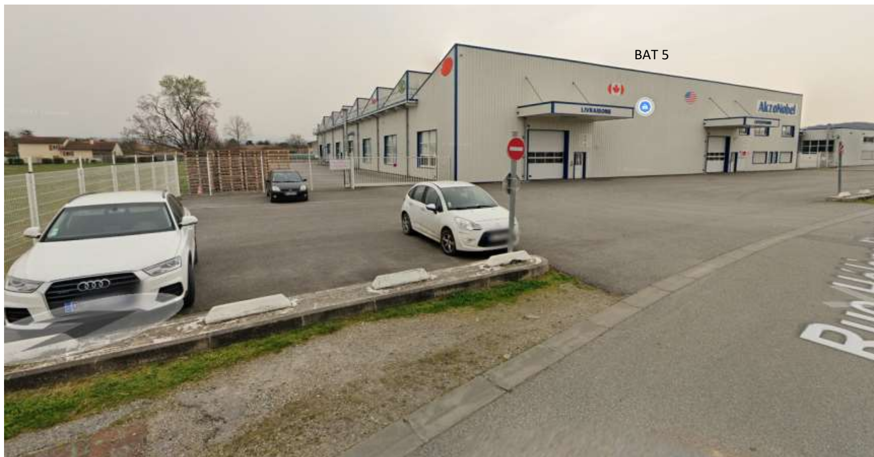
Figure 17: Photo 3 (Google Street View - Mars 2021) : Nord-Est du site et Bâtiment 5
