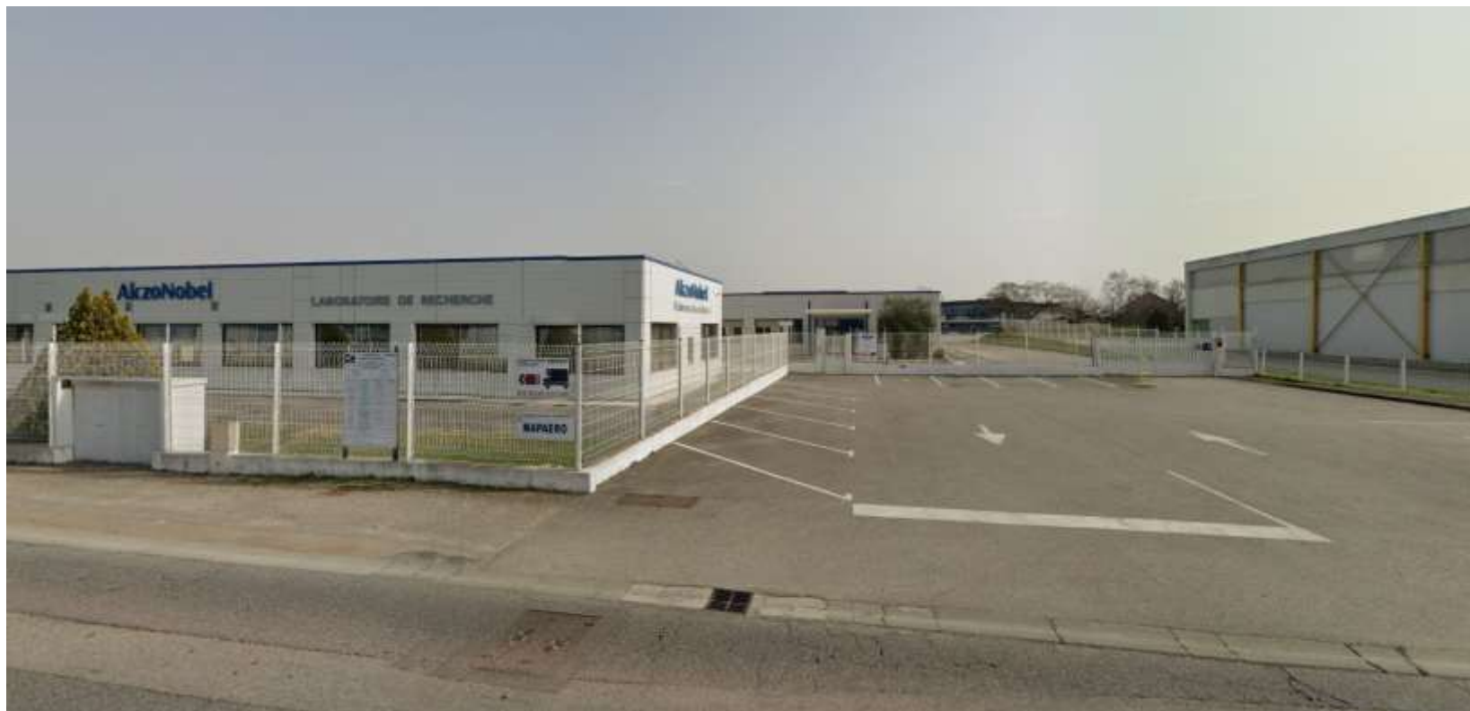
Figure 18: Photo 4 (Google Street View - Mars 2021) : Ouest du site – Bâtiment administratif et Laboratoire de recherche
