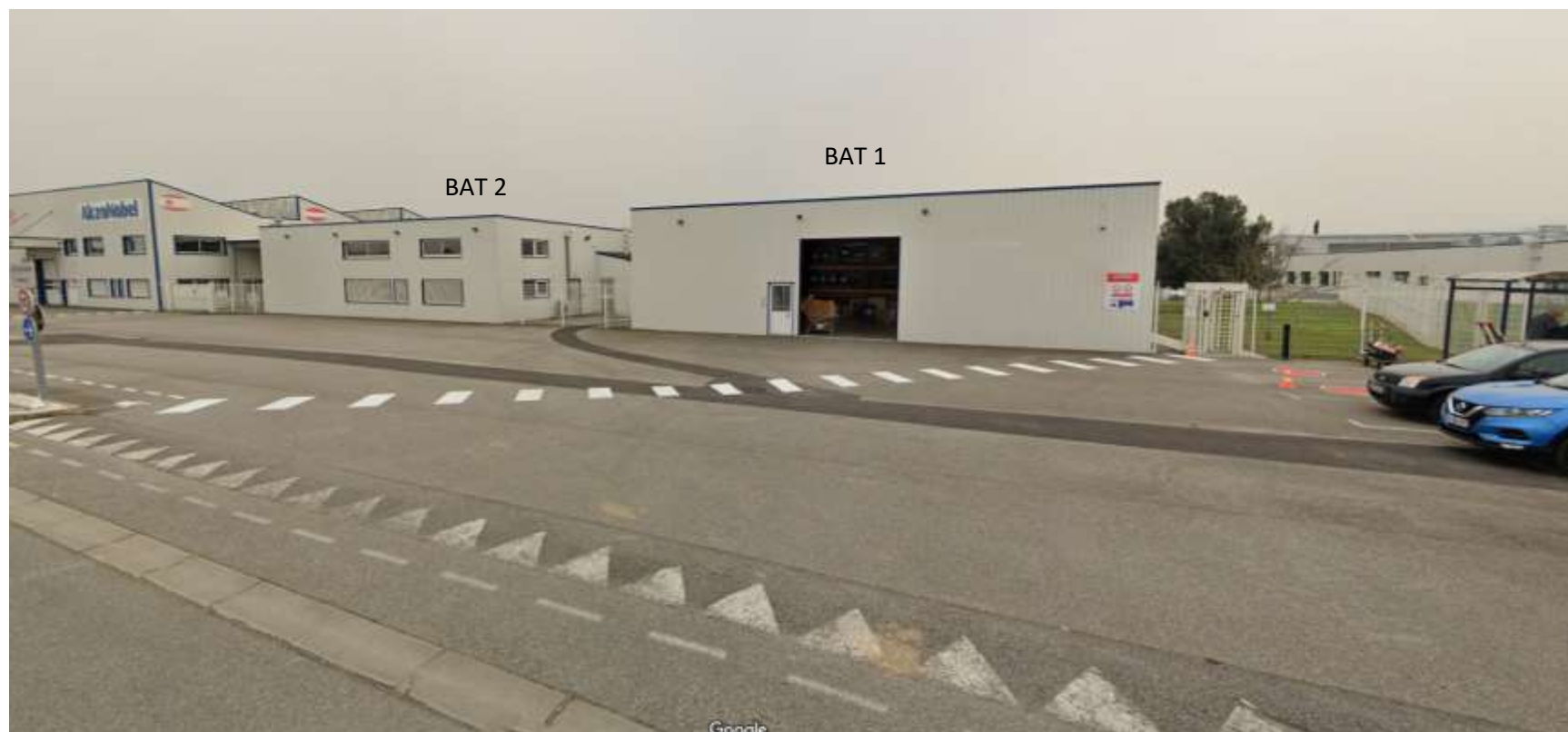
Figure 16: Photo 2 (Google Street View - Mars 2021) : Nord-Ouest du site
